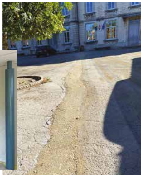
tranchée pour passage câble visiophone
